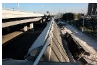
Bron kollapsade i morgontrafiken
